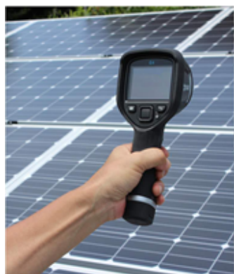
サーモグラフィによる発熱測定
