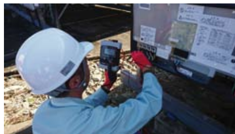
接続箱の端子から測定中
